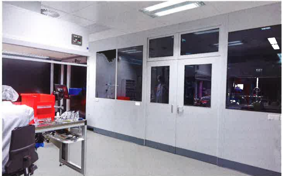
Das gesamte Wand- und Decken-System, das bei Trumpf verwendet wurde, ist freistehend. Zudem ist die Raumanlage modular aufgebaut und dadurch sowohl leicht erweiter- als auch demontierbar.
