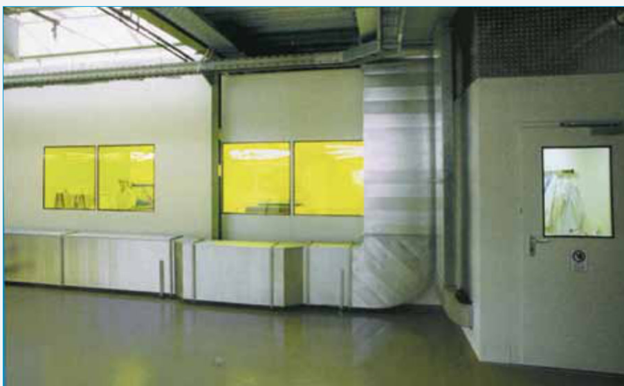
In die Wand integrierte Anlagentechnik
