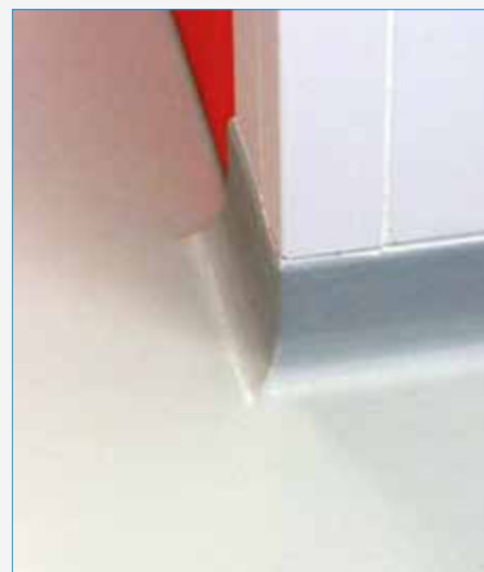
Ausgeführte Hohlkehle
