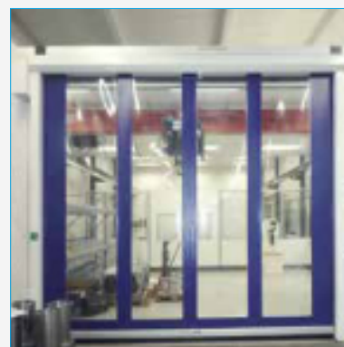
Abtrennung der Vortemperierzzone mit Stellwand und Folienschnellaufator
