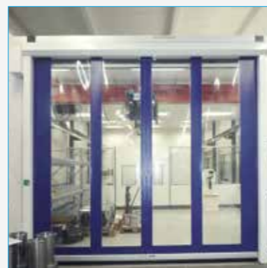
Abtrennung der Vortemperierzzone mit Stellwand und Folienschnellläufer
